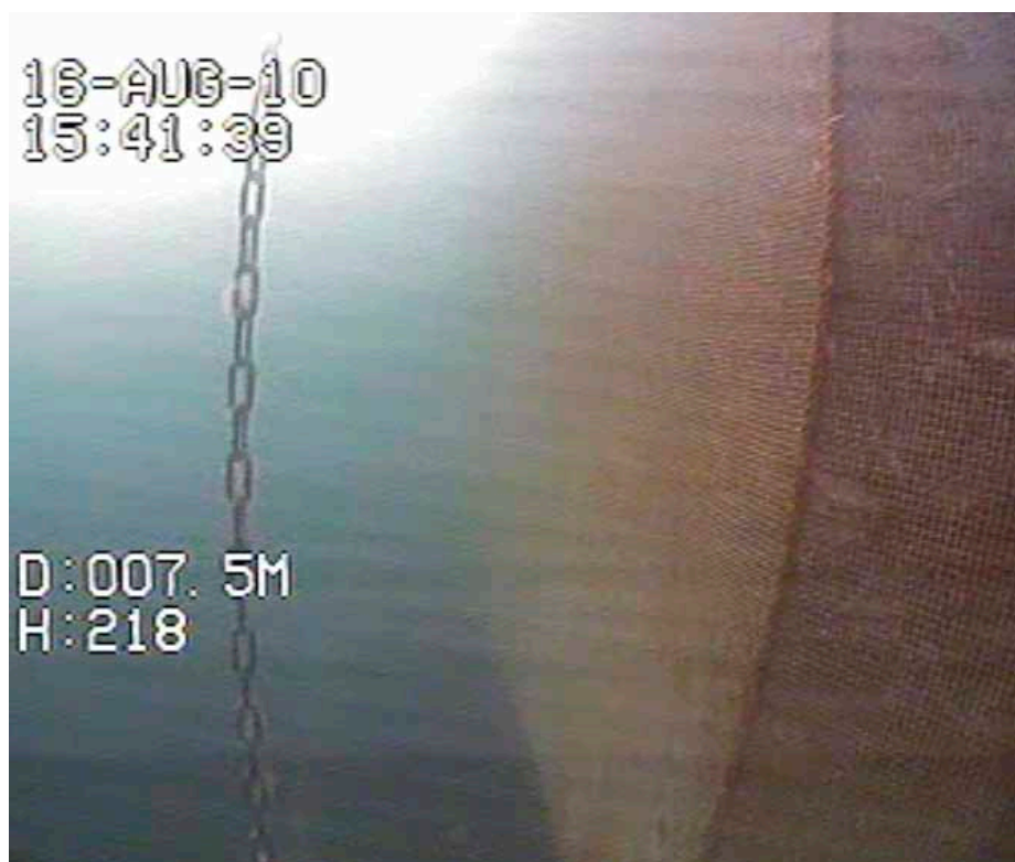
Notvegg deformert bort fra bunnkjetting.
